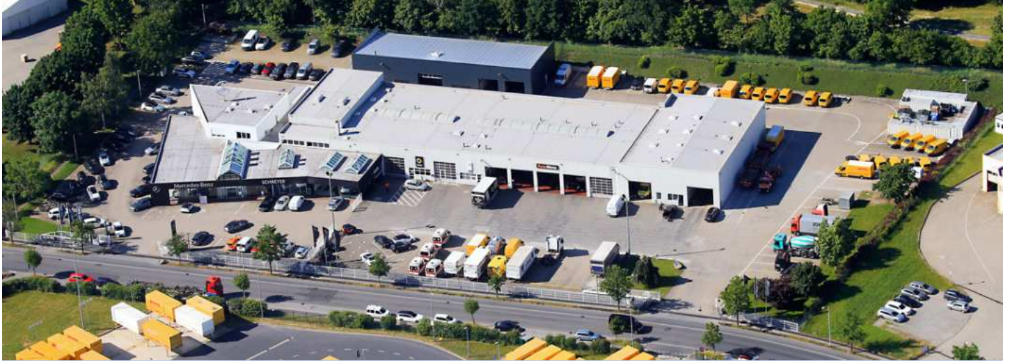
Ein aktuelles Luftbild des Firmengeländes in Ottendorf-Okrilla
